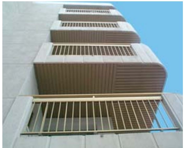
Obra: Viviendas en Salou
