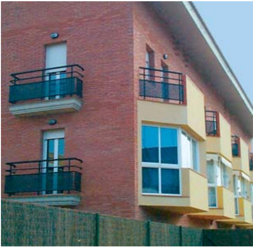
Obra: Viviendas en Castelldefels
